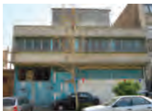
نمای ساختمان قبل از بازسازی
