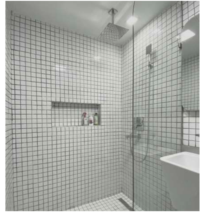
حمام-بعد از بازسازی
